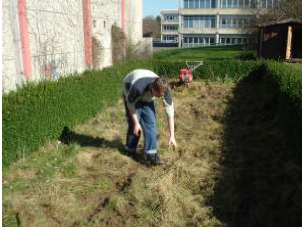
Ableasen der Grassoden nach dem Fräsen mit der Motorhacke
